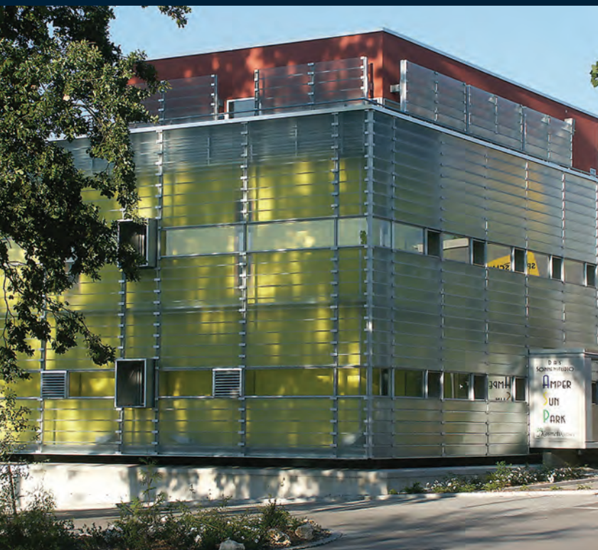
Облицовка фасада здания. Solar low iron matt
