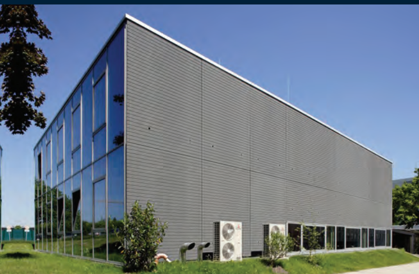
Реконструкция лабораторного блока при Департаменте строительства университета RWTH Aachen. Впервые были использованы элементы betoShell® XXL. Архитектурное бюро: Weiss-Schatzke Dipl.-Ing. Architekten, Aachen. Фото Robert Mehl
