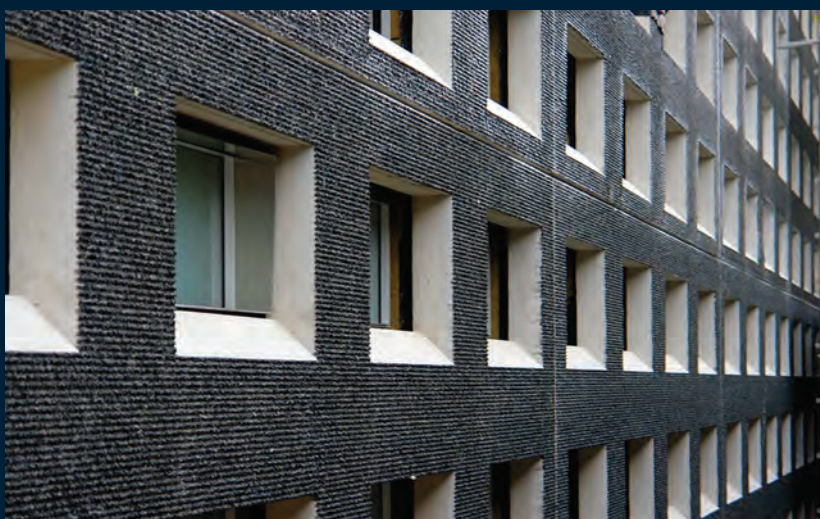
Благодаря специально изготовленной опалубочной конструкции, фасад офисного здания KMAR в Амстердаме имеет необычную текстуру, похожую на плетёный ковер. Архитектурное бюро: Wansleben Architekten, г. Кёльн
