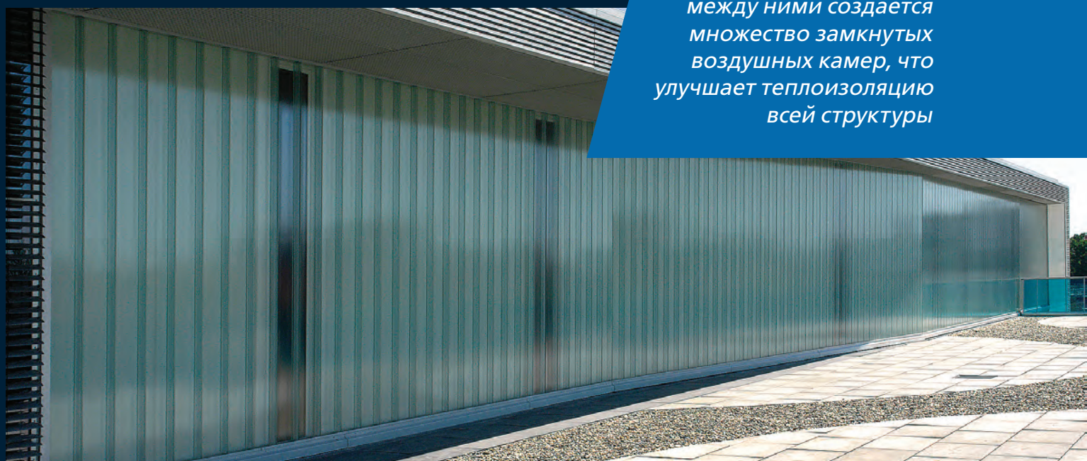
Фасад здания с полупрозрачным утеплителем. Perl 504
